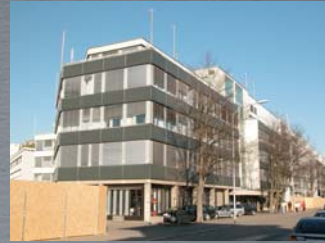
Sanierung Flur- hof, Zürich-
