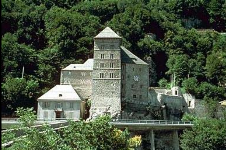
Fondation du Château de St-Maurice
